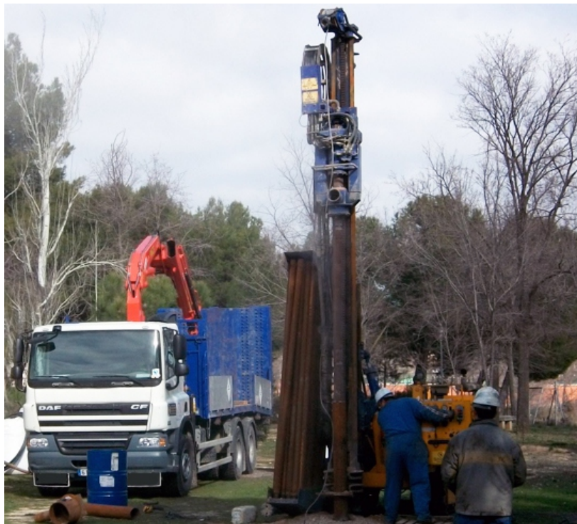
Imagen 3.1 - Perforación del sondeo piloto.
