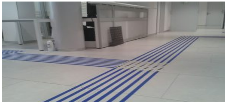
Figura 13: Pavimento podotáctil, recuperado de ( https://puntodis.com/featured_item/pavimento-podotactil-tactovisual-new-color-text/ )
