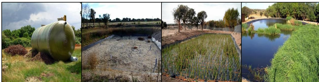
Figura 3.4. EDAR de Monleras, (España). De izquierda a derecha: Tanque Imhoff, humedal de flujo subsuperficial vertical, humedal de macrófitos en flotación y humedal artificial.
