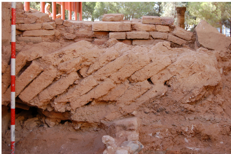
FIG. 5. Detalle del derrumbe de adobes ubicado en la esquina.
