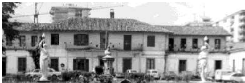
Figura 198: Antigo Hospital municipal de Irún. Archivo municipal de Irún
