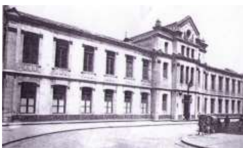
Figura 114: Escuelas de Solokoetxe, 1913 Archivo municipal de Bilbao
