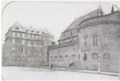
Figura 75: Estrarsburgo. Edificio construido para la asistencia dental infantil Biblioteca Nacional de España
