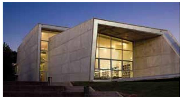
Su forma favorece la ventilación cruzada que junto con el sistema de climatización del suelo radiante (por energía geotérmica) y al cerramiento con gran inercia térmica posibilita un acondicionamiento térmico óptimo. Sus espacios se organizan en tres plantas y de forma lineal. Se abre al norte y al sur intentando eludir todas aquellas vistas que puedan distraer a sus usuarios y para controlar las luces, directas o reflejadas, que puedan molestar en su actividad.
