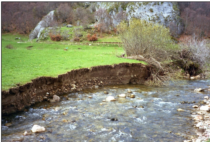
Figura 43.- Incisión vertical del cauce de 1m de altura aproximadamente.
