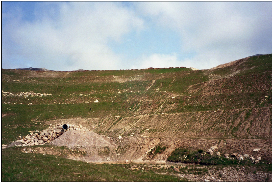
Figura 33.- Entubado final antes de la balsa de sedimentación.
