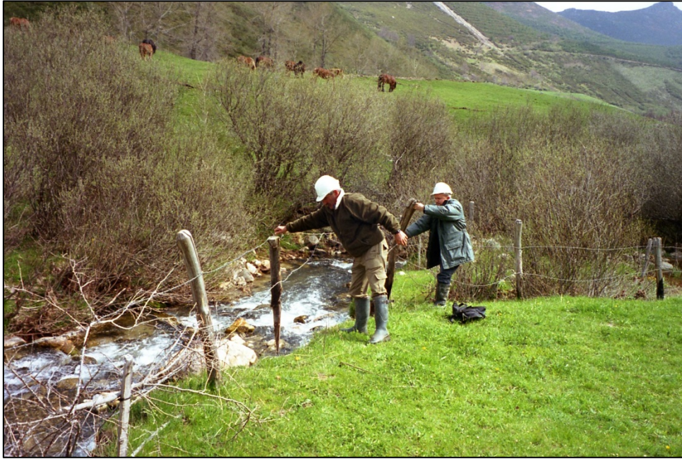
Figura 37.- Alambrado suspendido en el aire tras los grandes deslizamientos ocurridos.
