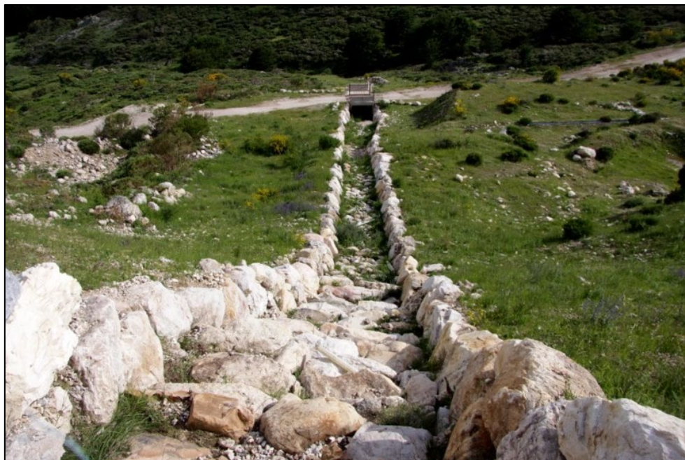
Figura 5.- Canal del aliviadero hasta la restitución al arroyo. Fuente: Sanchis, 2018
