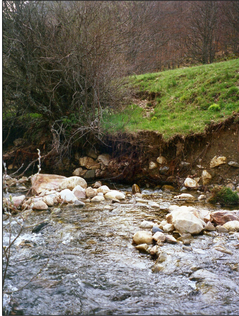
Figura 42.- Deslizamiento vertical del cauce con aporte de carga de sedimentaria.
