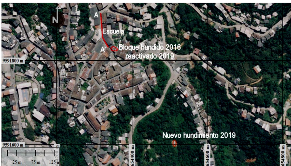
Figura 62. Ubicación de la escuela, bloque de aulas colapsado en 2016, reactivación del hundimiento en la escuela y nuevo colapso en el sector Gonzalo Pizarro 2019. Tomografía eléctrica línea roja A-A'.
