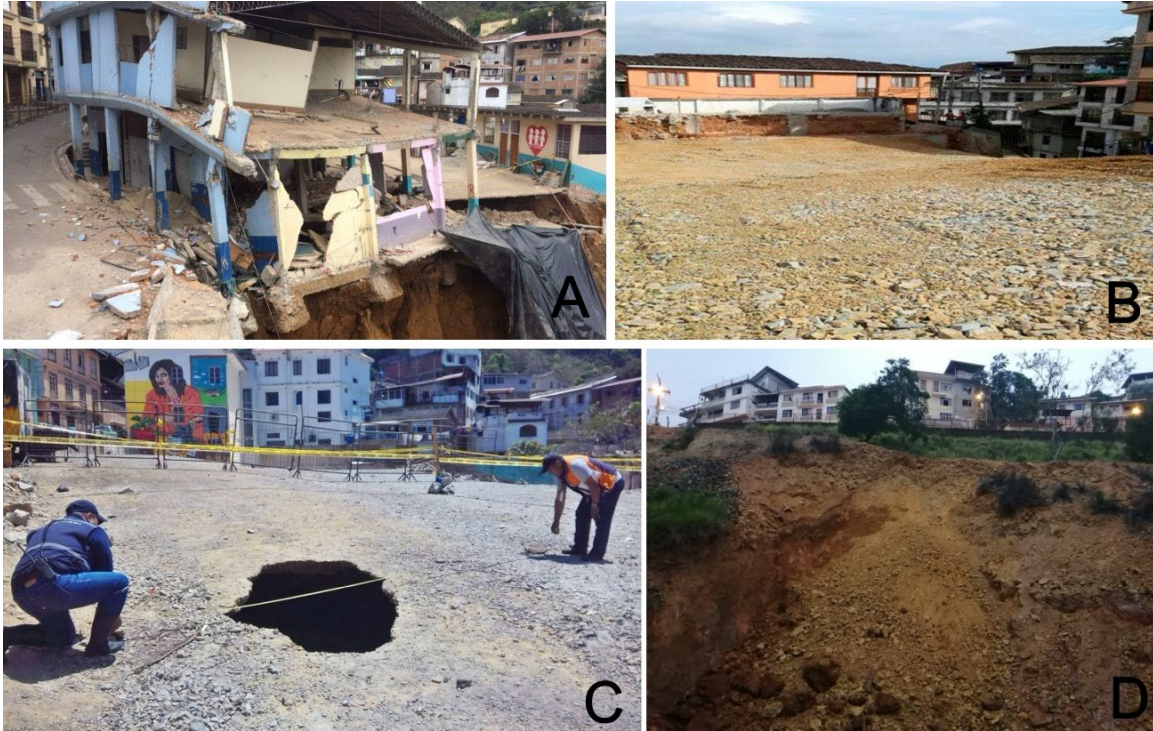
Figura 63. (A) Colapso de la escuela Fe y Alegría, en octubre de 2016. (B) Llenado técnico realizado en el sitio en 2017. (C) Reactivación del colapso en el lugar donde estaba la escuela en 2017. (D) Nuevo colapso cerca de la calle Gonzalo Pizarro en 2019. Imágenes tomadas del periódico El Expreso, Ecuador en vivo, página de Facebook Pichincha Universal y Arden los Socavones.
