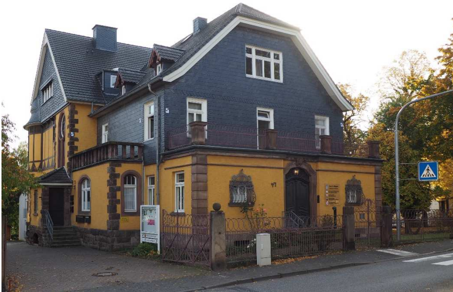
Figura 31 Fotografía del edificio.
