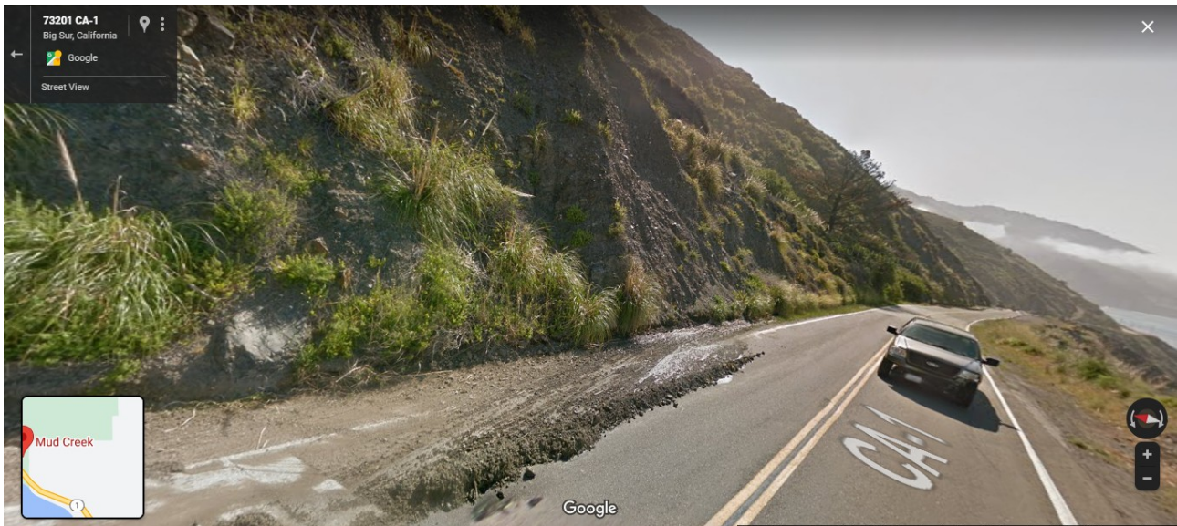
Figura 3.3-5.: Vista de Mud Creek. Fuente: Google Street View
