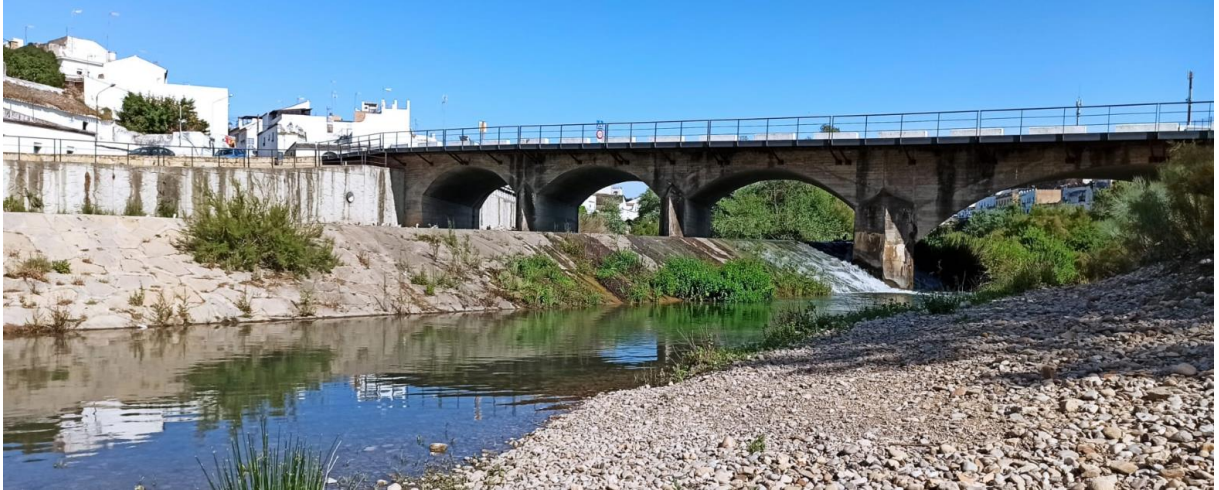
Figura 67. Puente de entrada, mismo que en la Figura 65.
