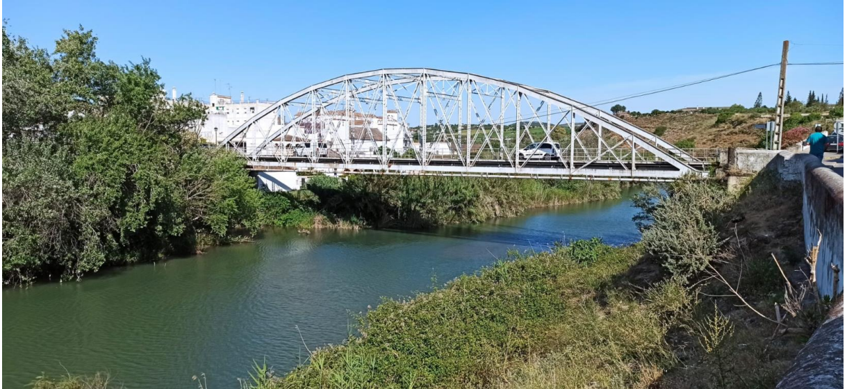
Figura 56. Estado actual del Puente de San Miguel. Mayo 2021.
