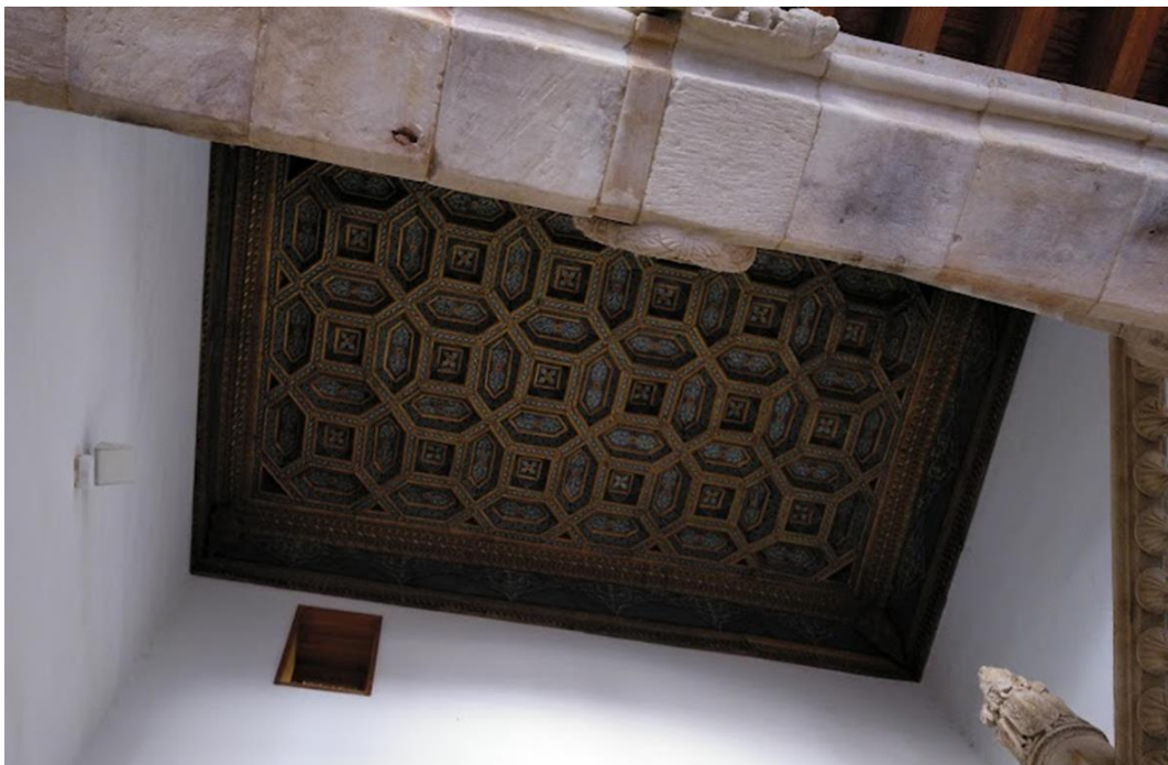
Fig. 21. Techumbre que cubre la caja de la escalera de la Casa de las Conchas.
