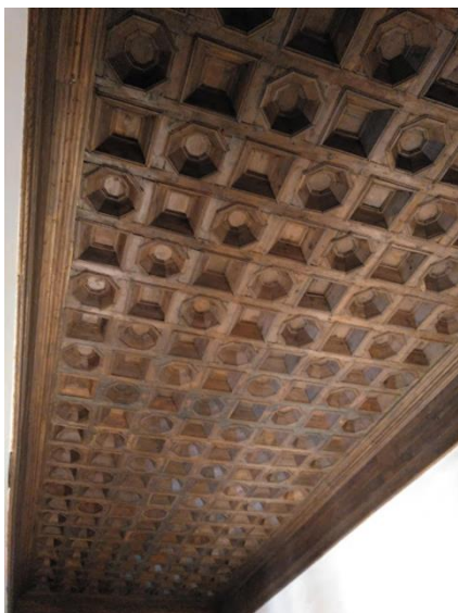
Fig. 23. Techumbre de la sala principal de la Casa de las Conchas. Noelia Soria Hernández, 2022.
