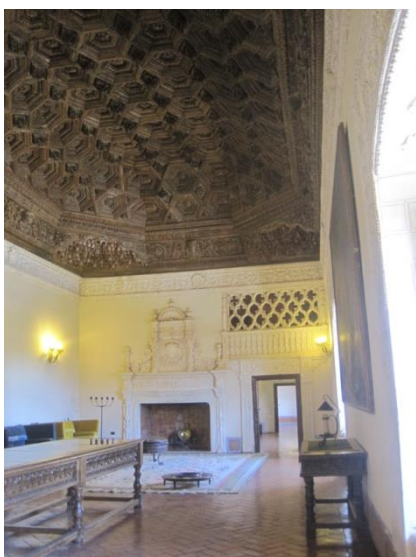
Fig. 24. Artesonado del Salón de Embajadores del Palacio de los condes de Miranda de Peñaranda de Duero, Burgos.
