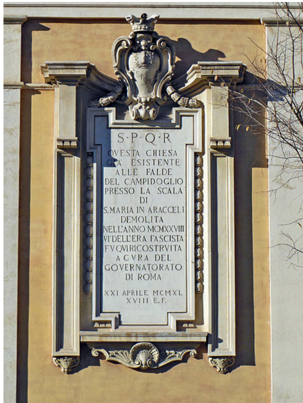
Fig.15: Imagen de la placa colocada en la parte lateral derecha. Fuente: MM
