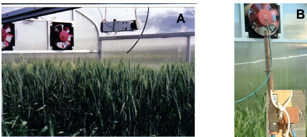
Fig 3.5. Sonda de aire y sensor de humedad y temperatura dentro del módulo inicial o de entrada (imagen A). Electroválvula y salida de CO 2 dentro del CGT (imagen B).
