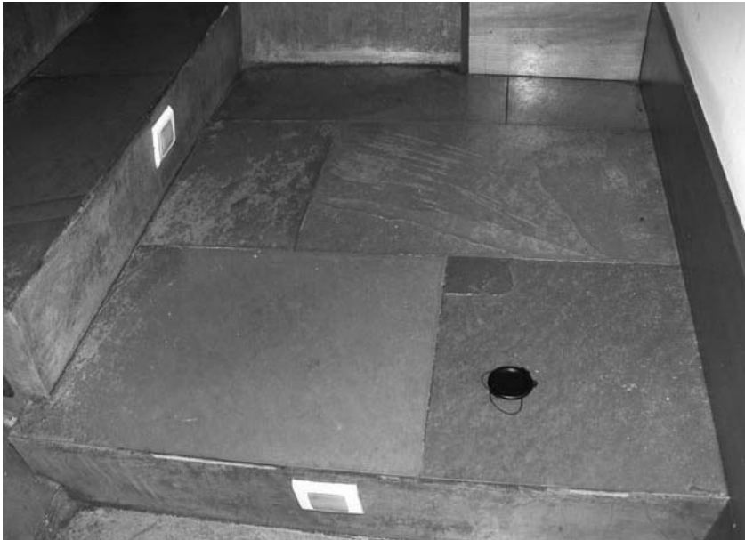
Figura 15.-Pizarras verdes. Escalera del bar "Momo".
