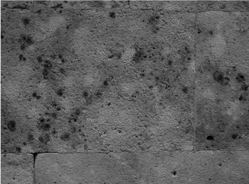
FIGURA 2.—Arenisca de Villamayor. Fachada del bar “Abadía”.
