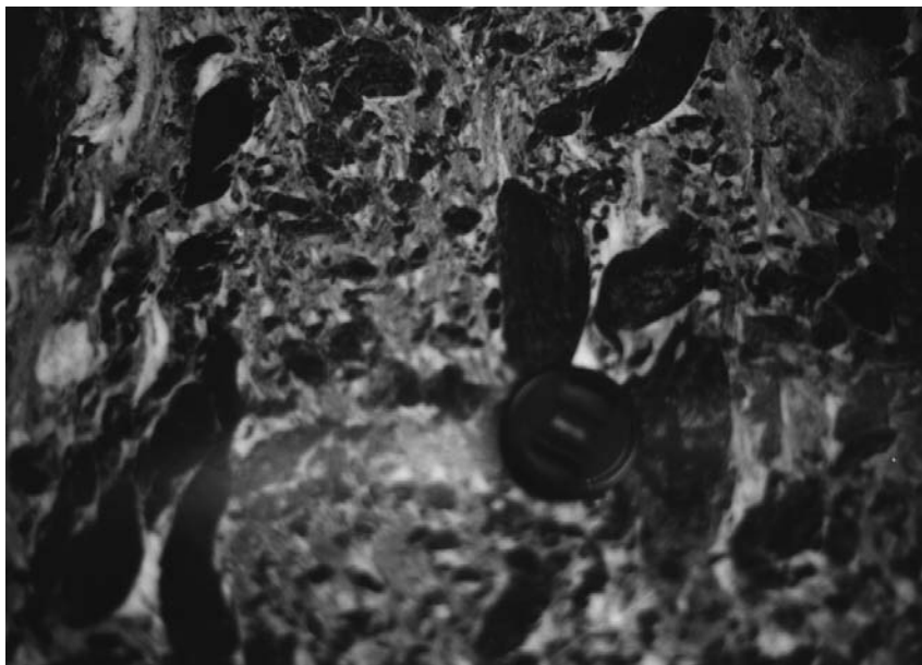
FIGURA 7.-Serpentinita en fachada del bar "Sebas".
