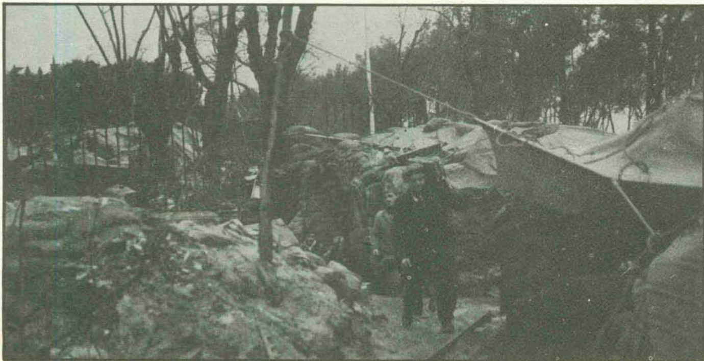
Construyendo trincheras en la plaza de la Moncloa, para detener a las fuerzas facciosas.
