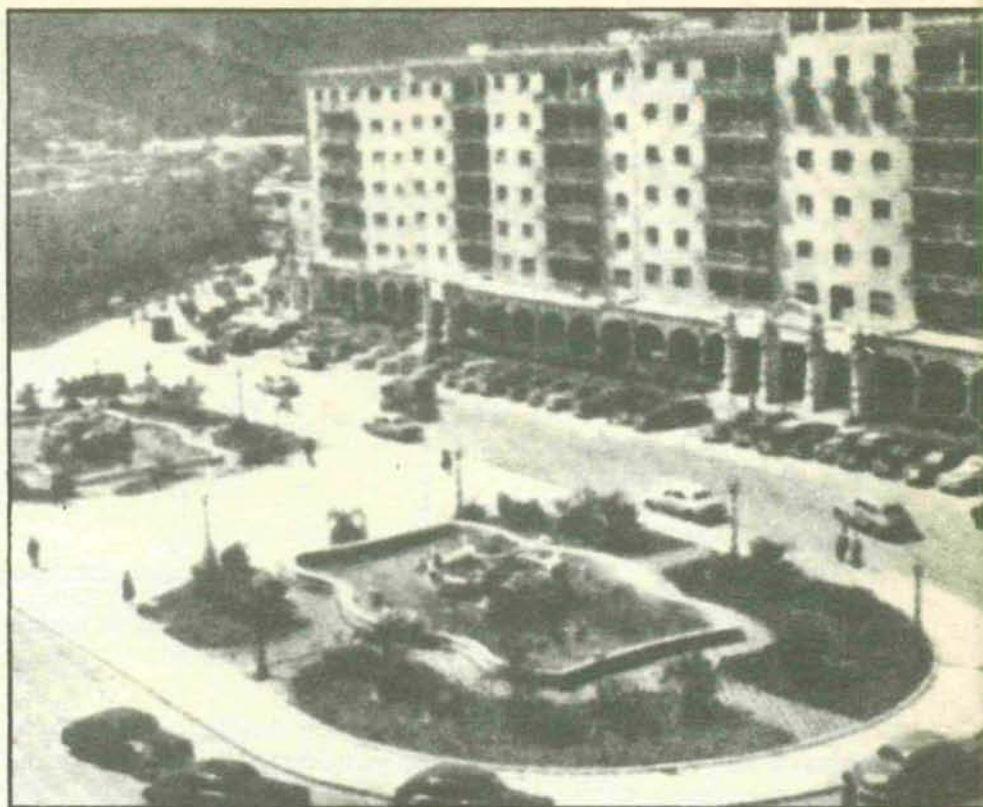
Vista parcial de un complejo de edificios en la avenida Bolívar de Caracas, en construcción cuando llegaron los primeros exiliados españoles.
