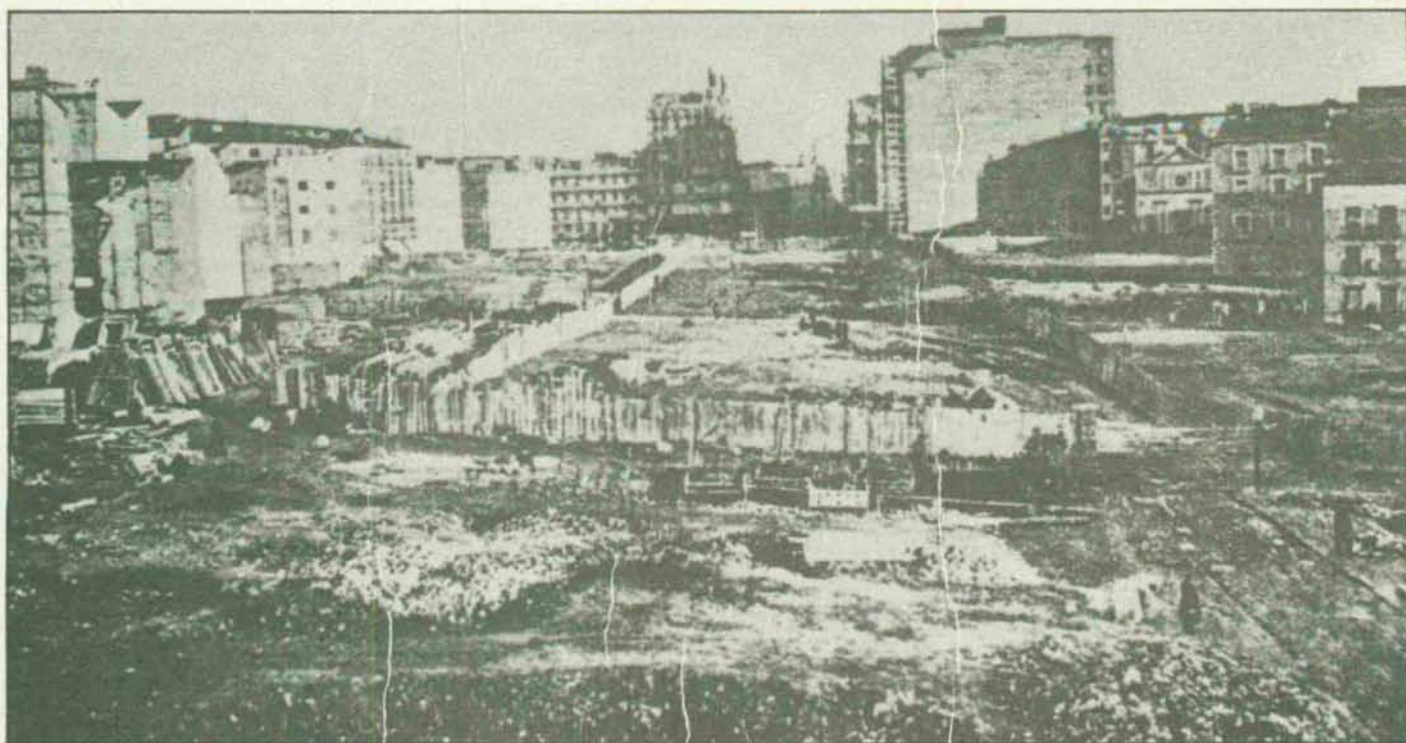
Con una piqueta de oro, Alfonso XIII inauguro solemnemente el comienzo de las obras de la Gran Vía el 4 de abril de 1910. Vemos dos aspectos ulteriores de las mismas: el trabajo en la Red de San Luis; y —sobre estas líneas— perspectiva del segundo tramo desde la Plaza del Callao.
