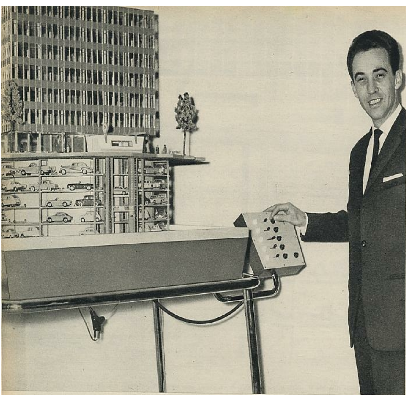
Una maqueta del «rotopark» en la que se aprecia el sistema de anillos con las vagonetas que transportarán los coches. En la superficie, sólo el pequeño quiosco indicará la existencia del aparcamiento.
