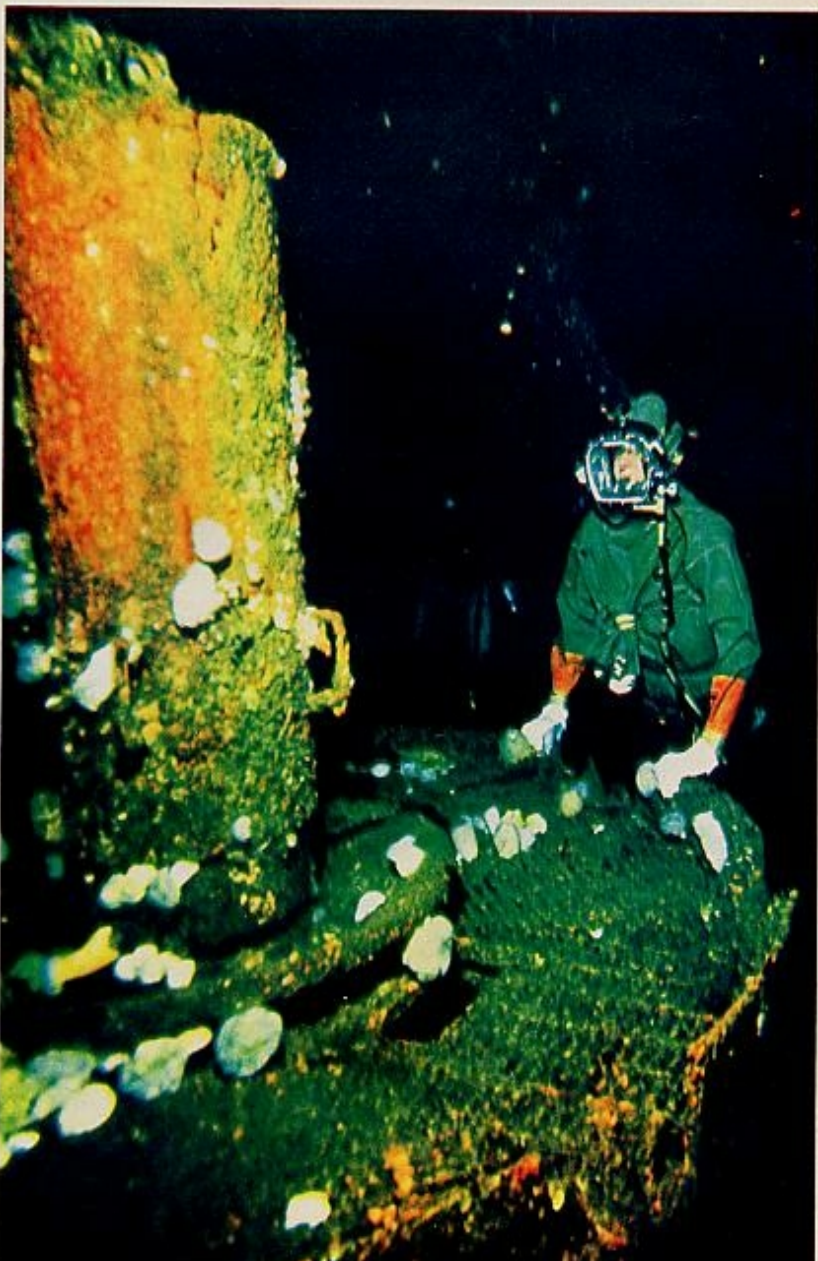
Arriba, montaje de una plataforma de producción situada cerca de Gabón, en la que trabajan buzos contratados por la Sociedad Francesa COMEX. Abajo, uno de los escafandristas de «Ocean Systems» durante su trabajo sobre una cabeza de pozo submarino en una de las abiertas a lo largo de California. Puede verse, al fondo, la camoana bi-esférica tipo «Purissiman».
