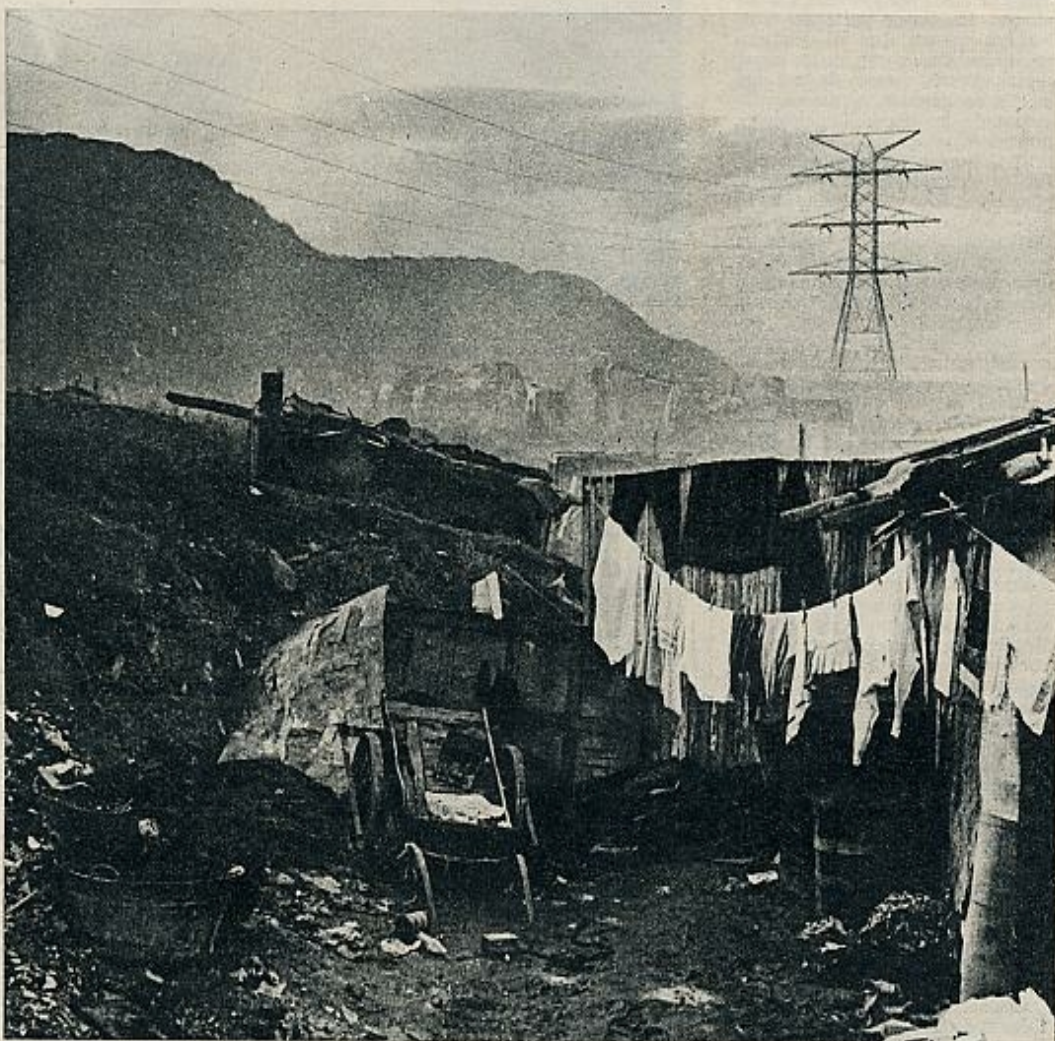
Las ciudades de chabolas crecen sin los servicios necesarios. Lo normal es que, como ocurre en el caso de la foto, las chabolas se monten en zonas de vertederos de basura, aguas residuales, escombreras, etcétera.
