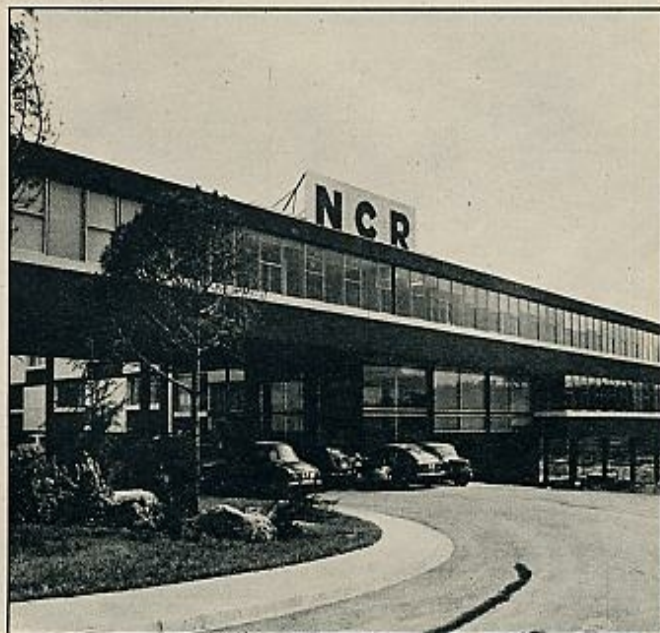
Vista del nuevo edificio que se levanta junto a la avenida de América, de Madrid, una de las zonas de mejor futuro en la capital de España.
