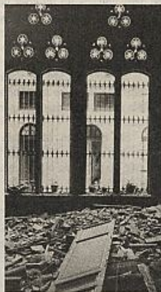
Ruinosa interior de la Casa Golferichs.
