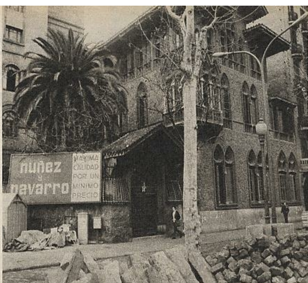
Fachada de la Casa Golferichs, esquina Gran Vía-Viladomat, joya modernista debida al arquitecto Joan Rubió i Bellver. En la verja, el rótulo de la inmobiliaria que se propuso derribarla.
