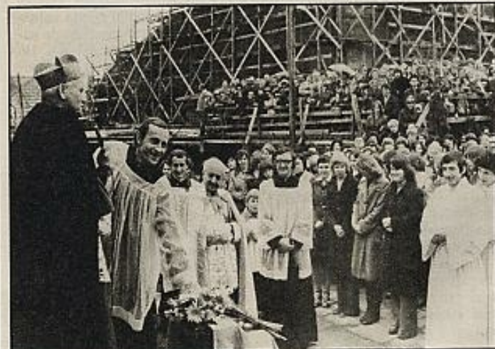
Karol Wojtyła, arzobispo entonces de Cracovia, ante una iglesia en construcción de su ciudad.
