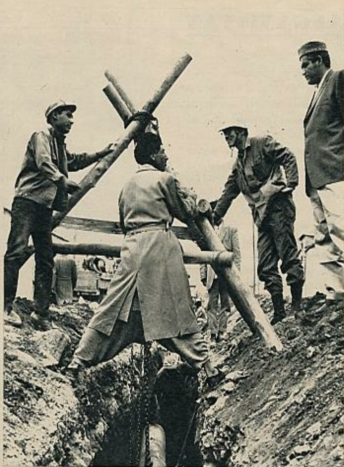
La educación se extiende también a la agricultura. Un ingeniero japonés instruye a sus colegas afganos en las obras de conducción de agua próximas a Kabul.
