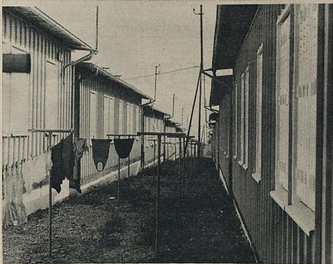
Casas prefabricadas en Puerto Lumbreras (patio interior). Las casas están construidas con plancha metálica en los techos y paredes exteriores. La chapa se recalienta con el sol, convirtiendo el interior en un auténtico horno.
