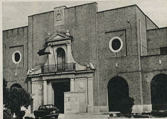
Aspecto parcial de la cárcel de Carabanchel.
