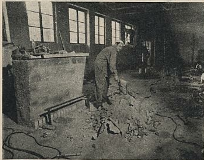
Aspecto del local donde hoy está instalado el centro español de Berlín, cuando se iniciaron los trabajos de acondicionamiento.
