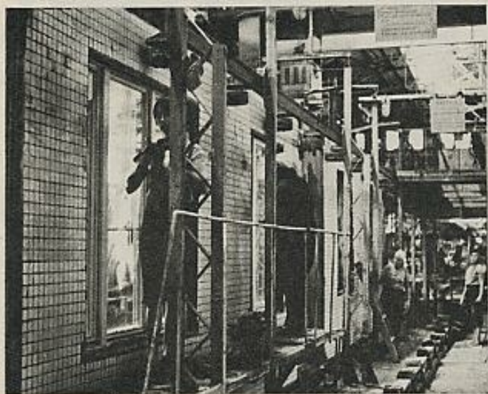
Lo esencial de la producción tendrá lugar en factoría, las operaciones en obra se reducirán al montaje.
