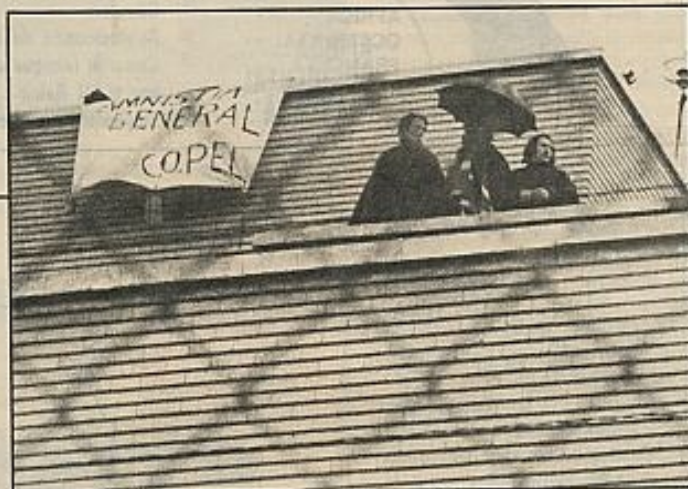
Reclusos en los tejados de Carabanchel. El motín fue sofocado por una brigada especial antidisturbios.
