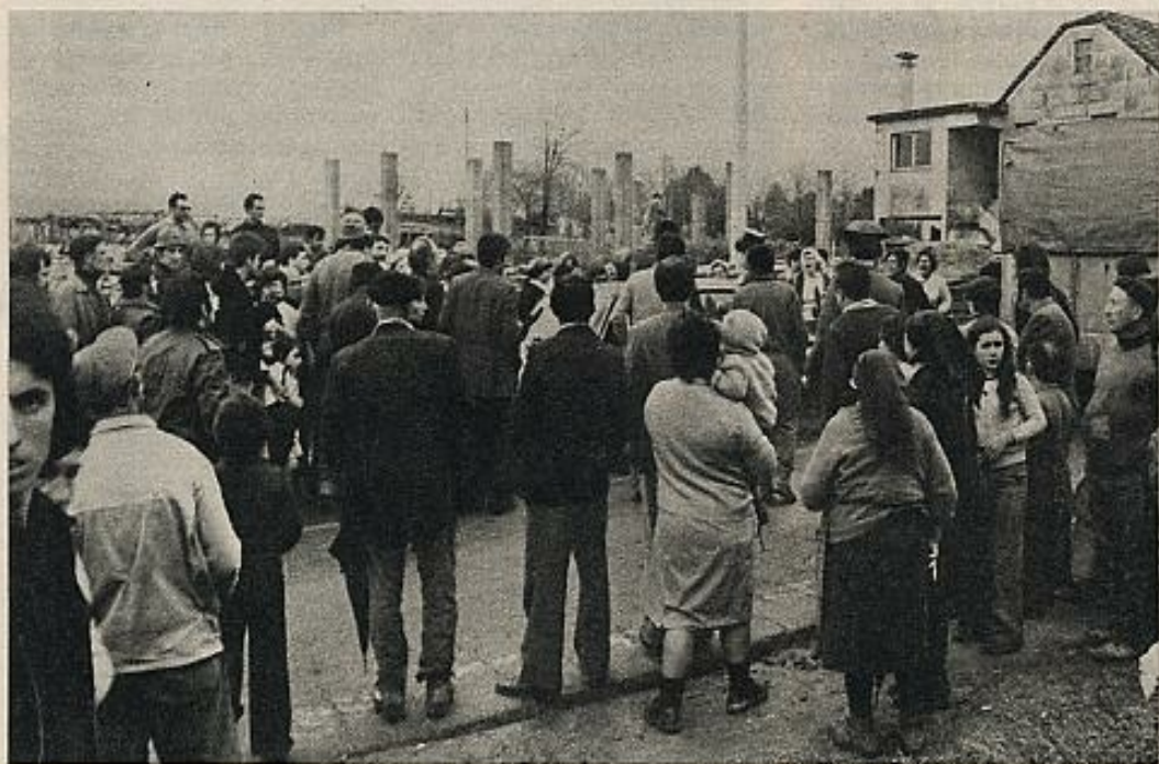
Tuvo que intervenir la Guardia Civil en varias ocasiones para contener los ánimos de la gente, cuando se ponía delante de las obras para paralizarlas.
