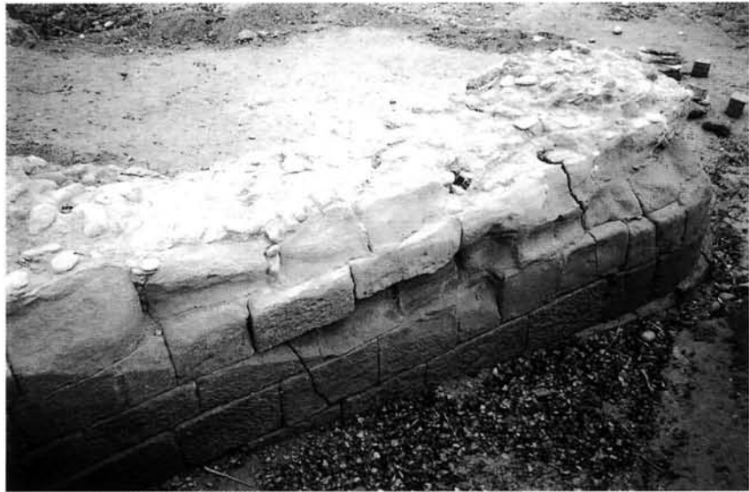
LÁM. 1: Vista del muro de aguas arriba de la presa
