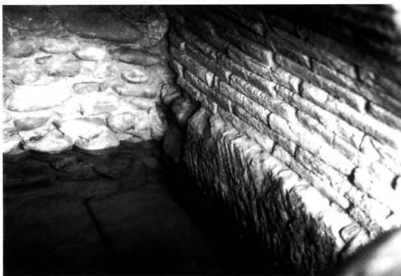
LÁM. 7: Detalle de la arqueta de decantación
