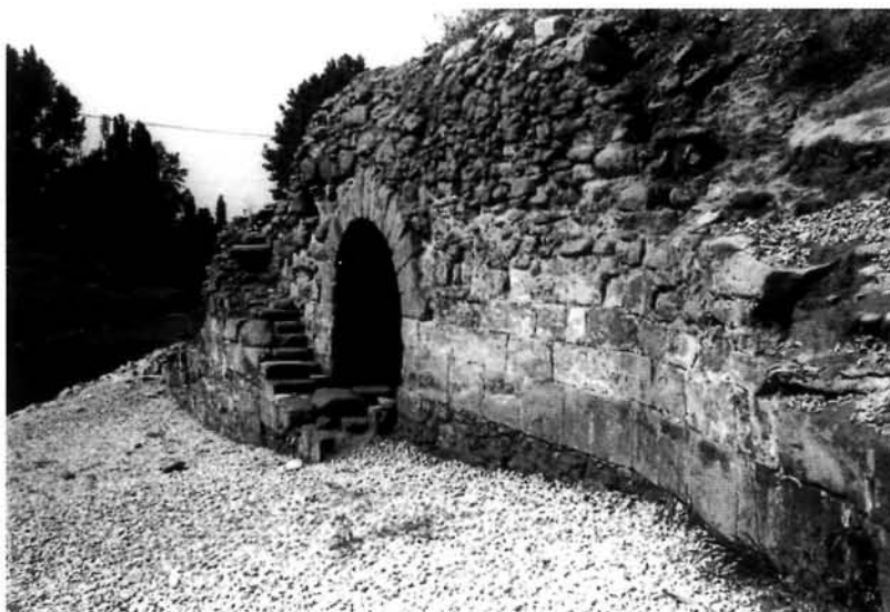
LÁM. 3: Vista de la manguardía del ninfeo. Obsérvense las tres fases identificables por las diferentes técnicas constructivas.
