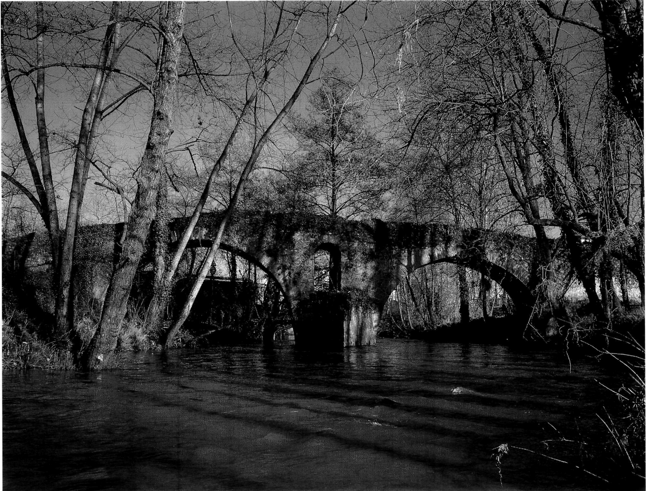
Foto 1. Vista frontal del puente desde el sector aguas arriba (Foto Dacar).
