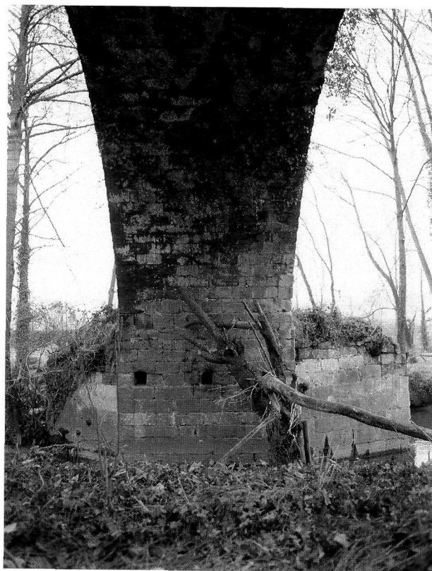
Foto 3. Detalle de los tajamares y del arco izquierdo (Foto Dacar).
