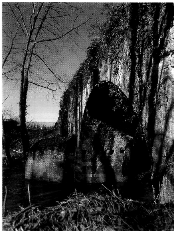
Foto 2. Detalle del tajamar y de la pila (Foto Dacar).
