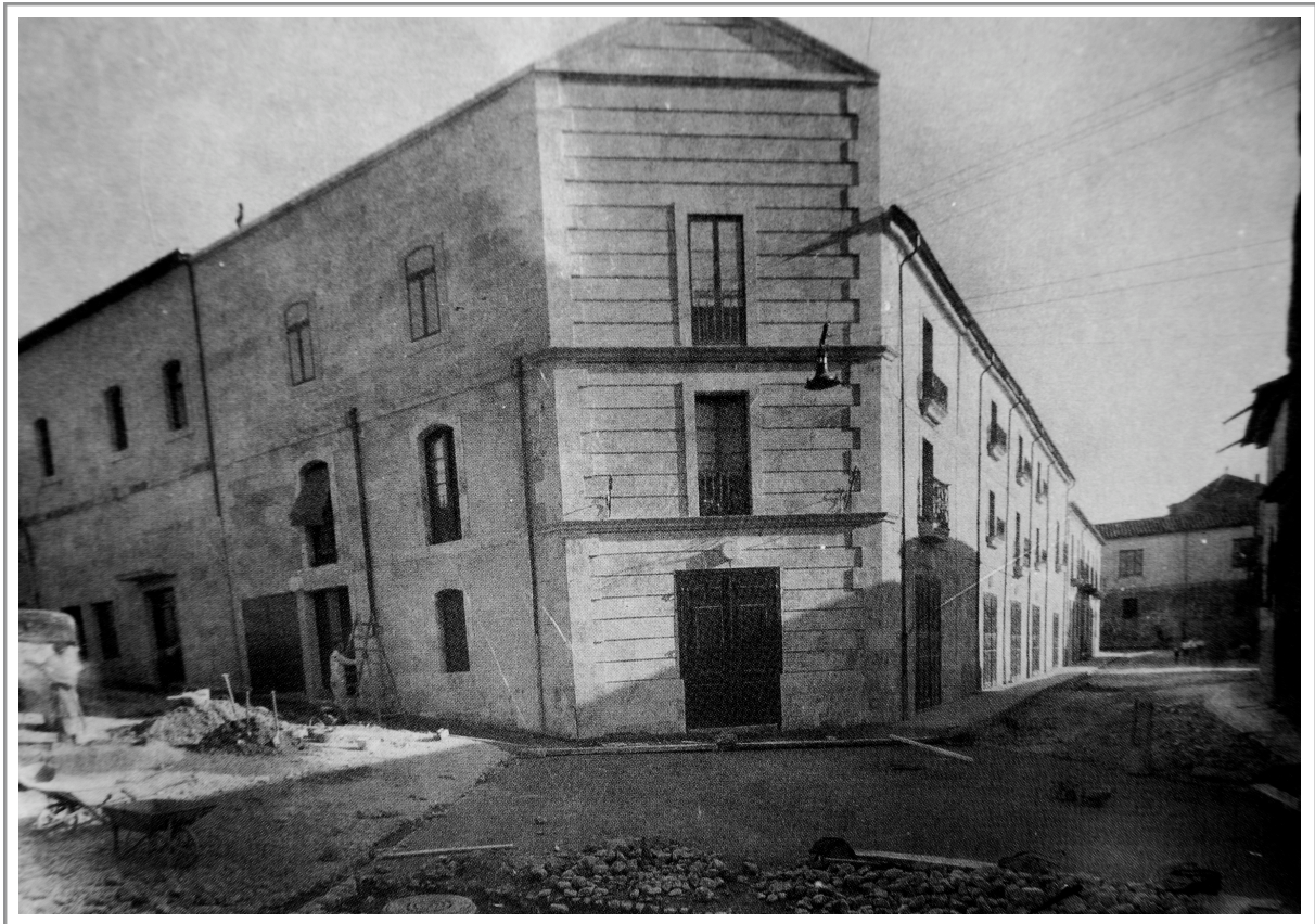
Ilustración 16: Fachada principal del teatro Bretón a comienzos del S.XX. Venancio Gombau.
