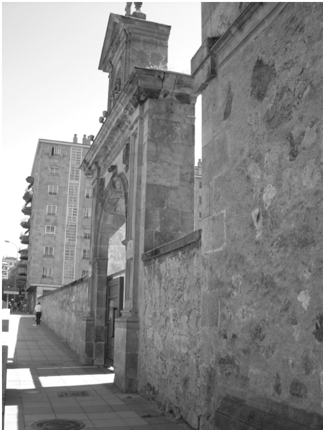
Foto 54. Campus de Educación: acceso desde el paseo Canalejas.
