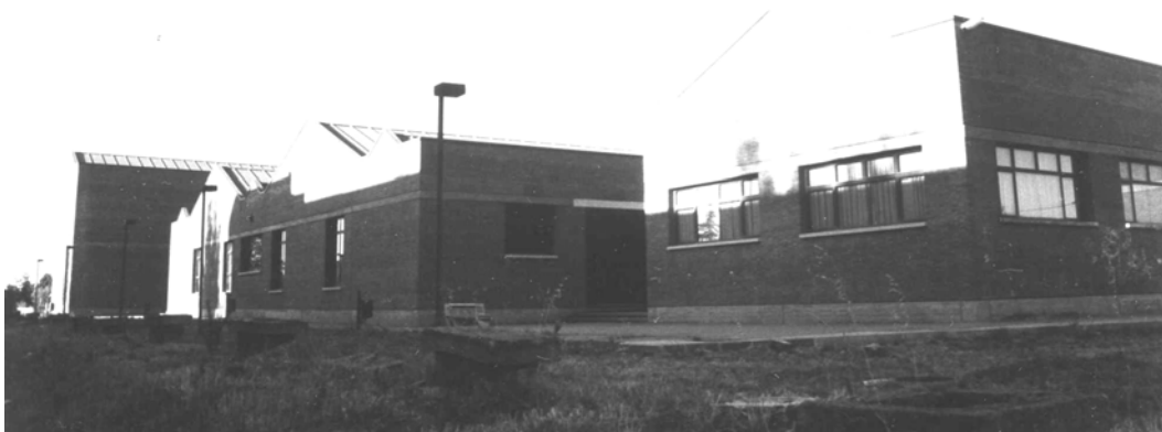
Foto 485. Edificio de Escultura y Dibujo: fachada principal
