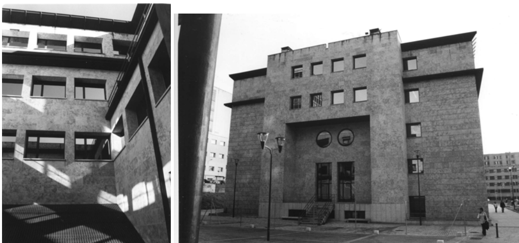
Foto 434 y 435. Escuela de Enfermería y Fisioterapia: patio interior y fachada norte.
