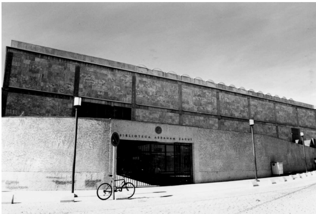
Foto 288. Biblioteca Abraham Zacut: acceso principal.
