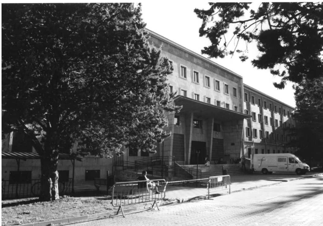
Foto 482. Facultad de Bellas Artes y Psicología: fachada principal.
