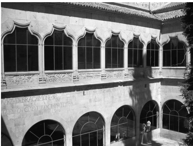
Foto 95. Claustro del edificio de Escuelas Mayores
