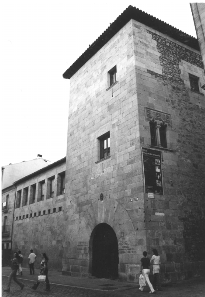
Foto 325. Palacio de Abrantes. Fachada a la calle San Pablo.
