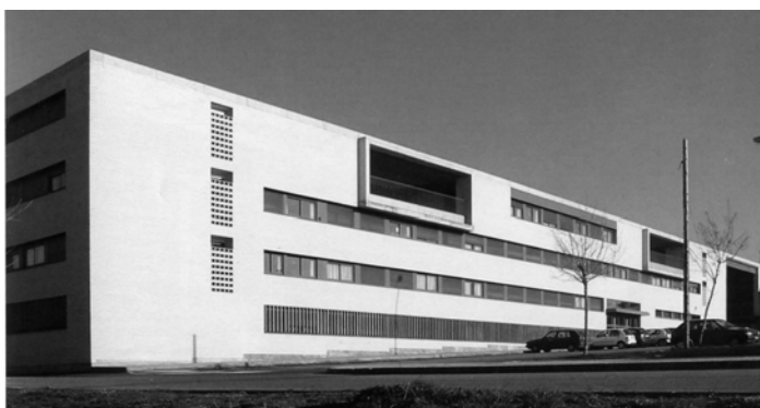
Foto 470. R. U. Colegio de Cuenca: fachada principal.
