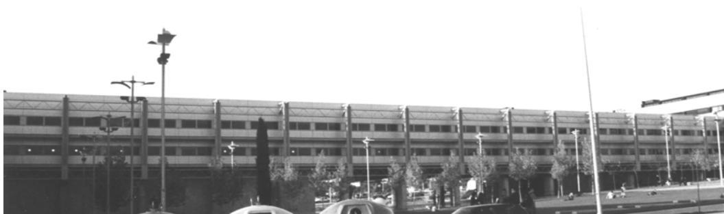
Foto 454. Biblioteca Francisco de Vitoria: fachada principal.
