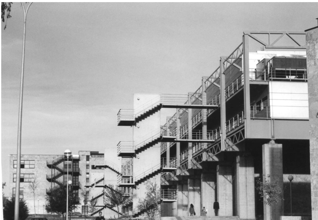
Foto 455. Biblioteca Francisco de Vitoria: fachada posterior.
