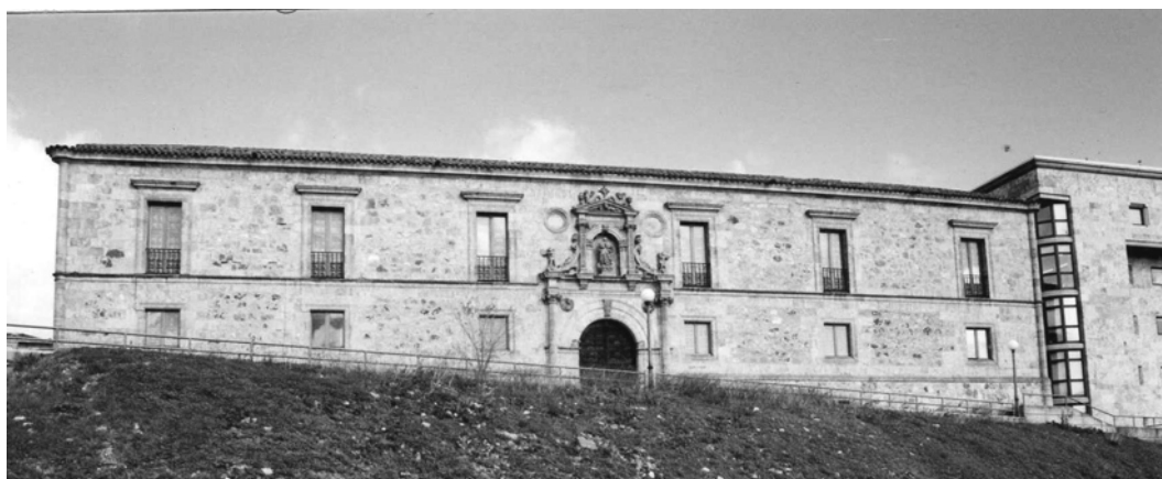
Foto 379. Instituto Universitario de Ciencias de la Educación. Fachada sur.
