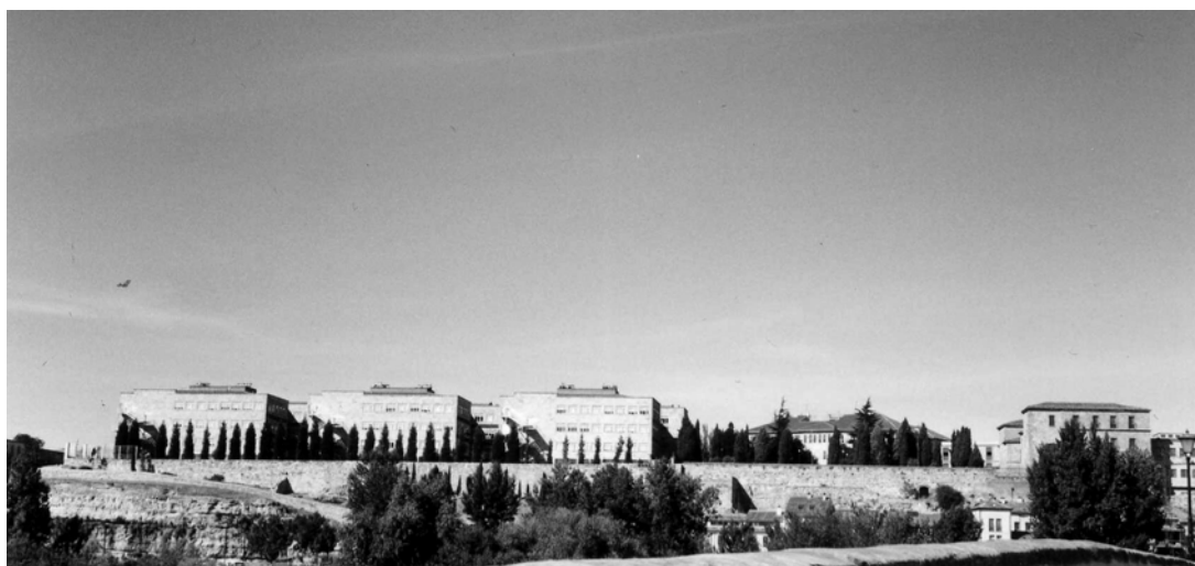
Foto 272. Facultad de Ciencias. Fachada Sur.
