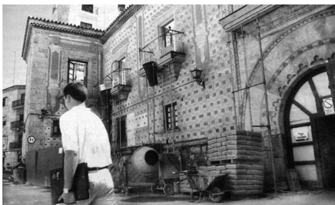
Foto 348. Palacio de San Boal: restauración de la fachada principal.
