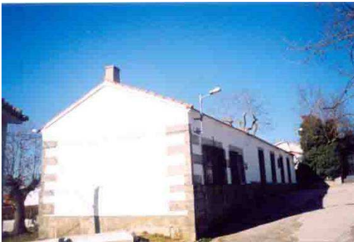
Imagen 41. Edificio escolar en Endrinal. El edificio escolar luce de color blanco tanto en el exterior como en el interior; esta resellado de hormigón (cemento). Pero la estructura física consta de piedras cortadas que están ocultas trás el hormigón; solamente se puede observar los grandes machones de piedras que sostienen
