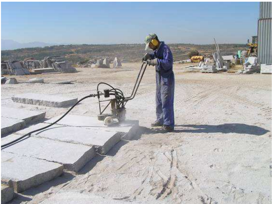
Imagen 13. El cantero. El cantero está picando piedra con puntilla de acero. La máquina que usa funciona a base de comprensión de aire. La fuerza del aire que produce la maquina hace bailar o girar las puntillas de acero con que va picando la superficie de la piedra.
