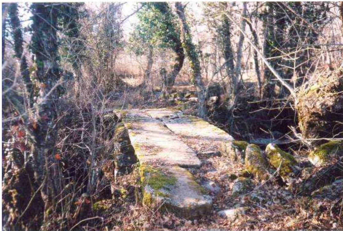
Imagen 17. El puente. El primer puente sobre el río Santa María construido de cuatro machones. El puente tiene tres sostenes hechos de piedra. Por este puente pasaban antaño personas, vacas y carretas jaladas por bueyes.
