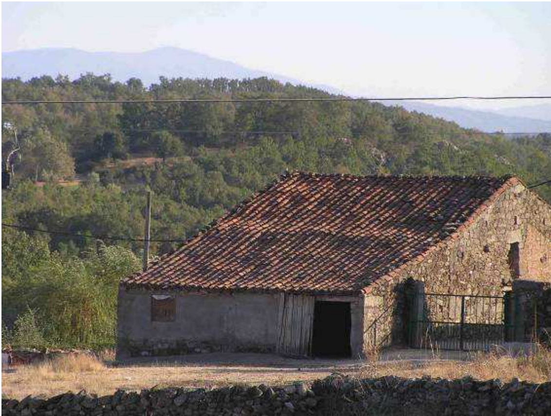
Imagen 21. La casilla antigua. Esta casilla sirve como un espacio para “encebadero”, o sea un lugar donde engordan y crían los cerdos. Los cerdos comen y duermen allí. Observamos que el techo de la casilla sufre un ligero desplome. Las vigas ya no soportan más el peso de las tejas de barro.
