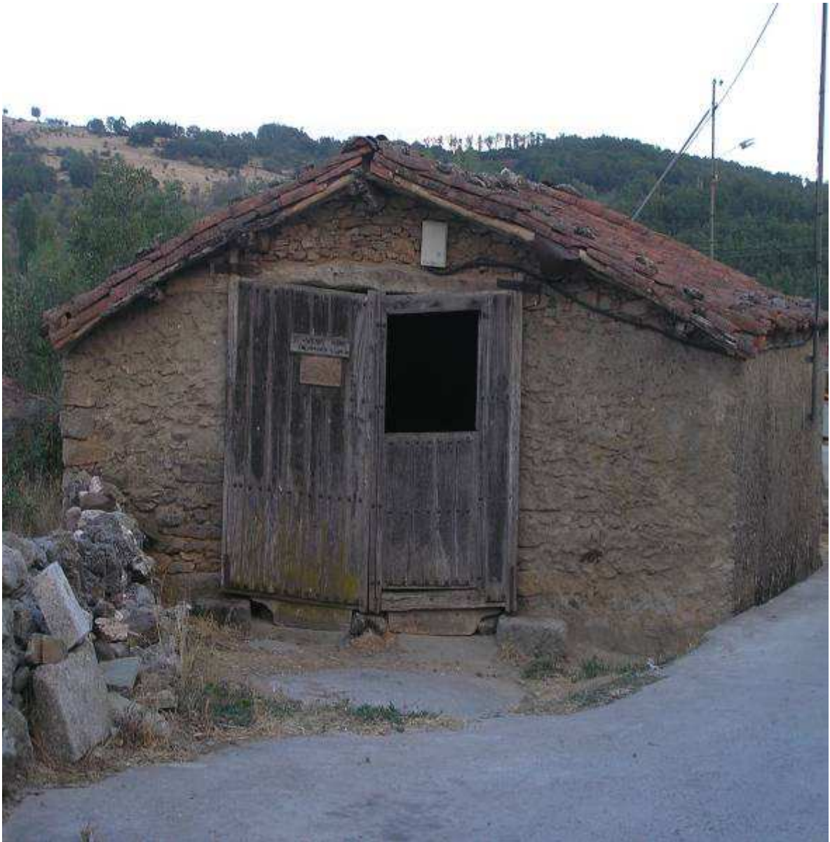
Imagen 24. Esta casa antiguo fue construida con cachos de piedras multiforme, con barro para unirlas. La casa tiene doble puerta de madera, una puerta principal que cubre la totalidad de la abertura y la segunda puerta queda a nivel medio y sirve como ventana.
