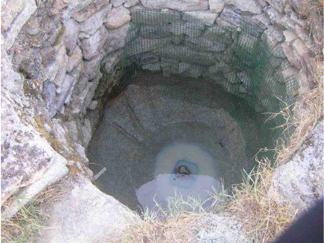
Imagen 19. Pozo subterráneo “boca abierta”. Este tipo de pozo se encuentra en la parcela de Juanito, está enmado y sirve para proporcionar el agua para el riego.
