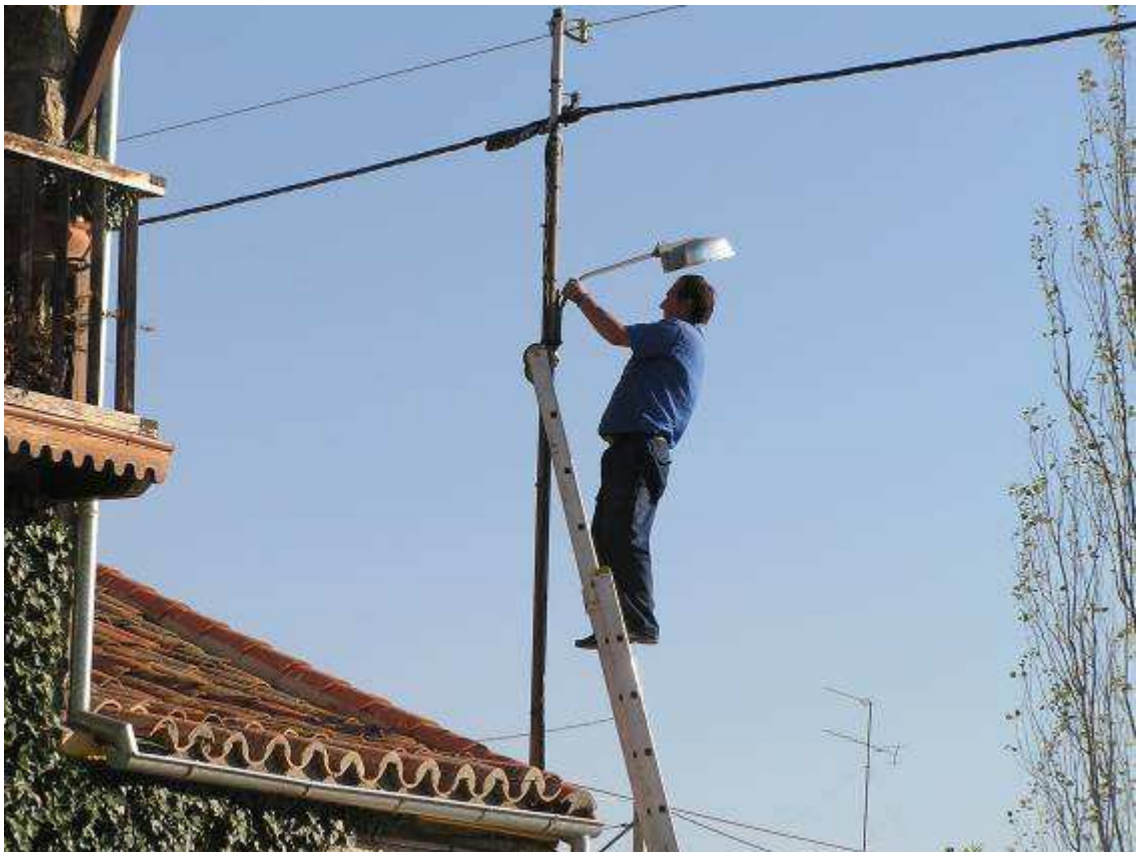
Imagen 9. Electricista. En esta foto, podemos apreciar al técnico electricista trepado en una escalera de aluminio. Al apoyarse con una mano, sostiene la lámpara con la otra; observa con atención el estado del foco. Si nota que está fundido, lo cambiará con un nuevo foco.
