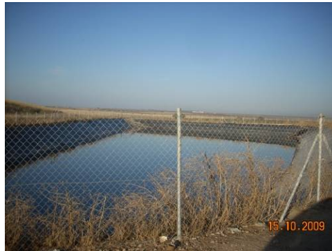
Balsa de lixiviado
