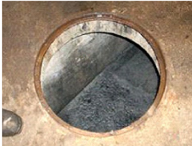
Figura 4.2. Arqueta para toma de muestra del lixiviado de compostaje (CTR de Burgos).
