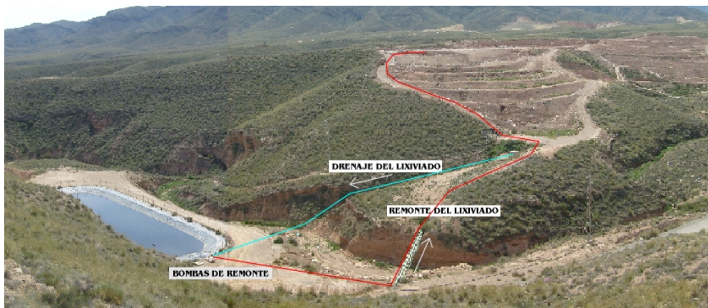
Figura 2.4.- Recirculación de lixiviado
