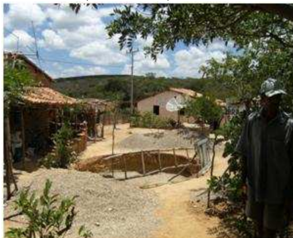
Figura 6.68 – Foto da construção de poço para armazenamento de água de chuva no povoado de Lata Cercada, Cafarnaum, Bahia.
