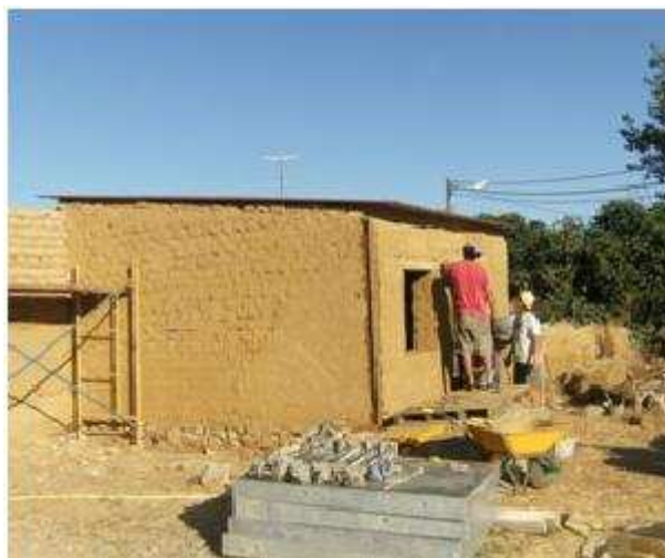
Figura 6.145 – Foto da Visão externa da casa bioclimática em construção.
