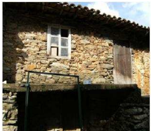
Figura 6.248 – Foto das casas mais antigas com mais de 500 anos na aldeia são confeccionadas com pedras as atuais estão sendo feitas com blocos cozidos.
