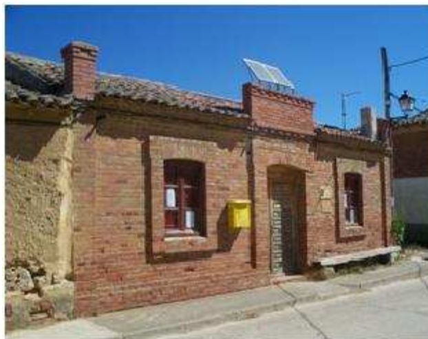
Figura 6.121 – Foto do Prédio dos Correios de Amayuelas de Abajo.
