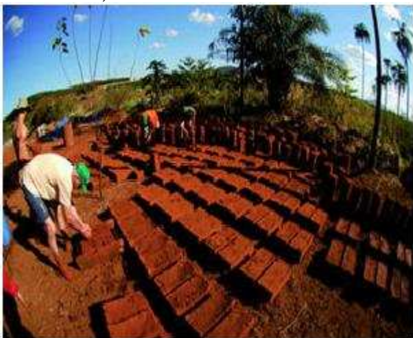
Figura 6.73 – Foto da fabricação de adobe para construção de residências em Lata Cercada, Cafarnaum, Bahia.
