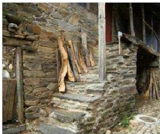
Figura 6.272 – Foto do detalhe de construção de uma casa centenária da aldeia.
