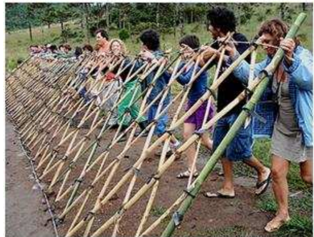
Figura 6.95 – Foto do momento de construção do yurt (Etapa 1.)
