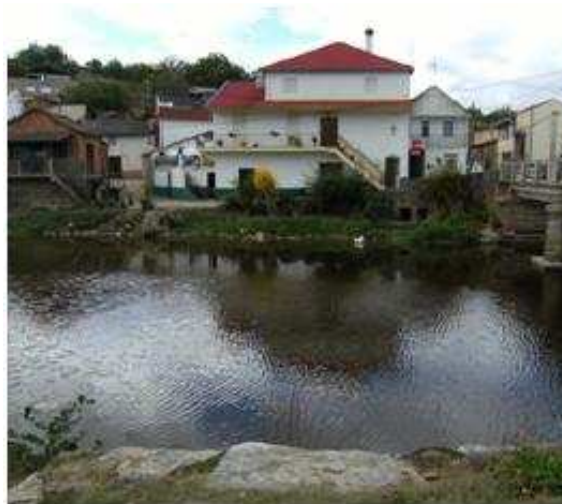
Figura 6.276 – Foto do detalhe da margem esquerda do Rio de Onor.
