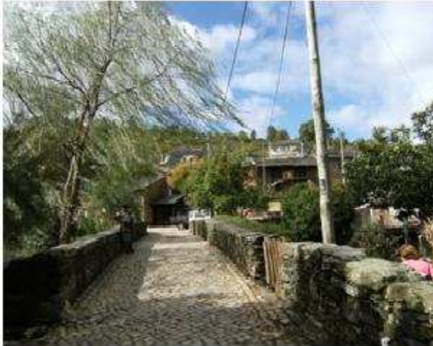
Figura 6.293 – Foto da ponte sobre o Rio de Onor.
