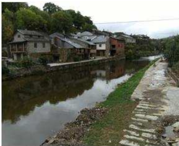
Figura 6.275 – Foto do detalhe do Rio de Onor que separa a aldeia em margens direita e esquerda.
