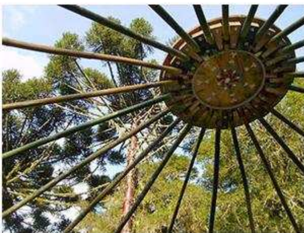
Figura 6.96 – Foto do momento de construção do yurt (Etapa 2).
