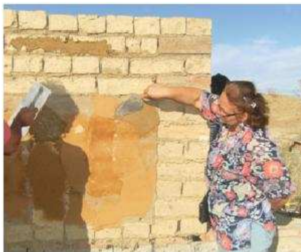
Figura 6.146 – Foto da Aprendendo a rebocar as casas (mostrando detalhes do reboco) durante o Curso de Bioconstrução.
