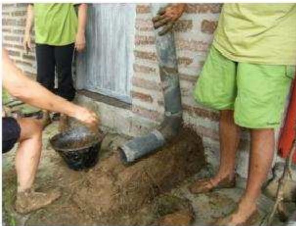
Figura 6.100 – Foto da construção do fogão a lenha atrás da casa grande (Etapa 2).
