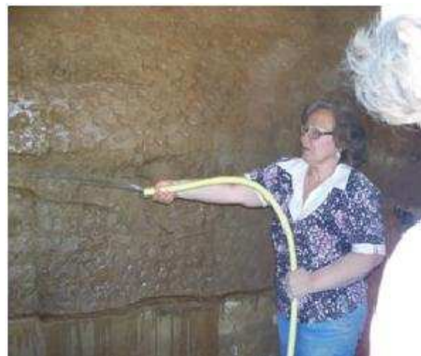
Figura 6.147 – Foto Trabalhando na construção do reboco da casa bioclimática.
