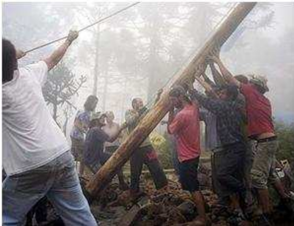
Figura 6.94 – Foto do momento de construção da cozinha comunitária da ecoaldeia.
