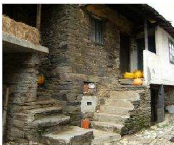
Figura 6.274 – Foto de uma residência centenária característica da aldeia, construídas utilizando pedra,
