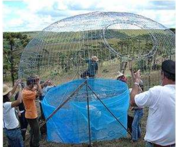
Figura 6.93 – Foto da construção do reservatório para coleta de água de chuva na ecoaldeia.
