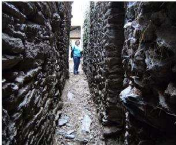
Figura 6.249 – Foto dos detalhes das residências cuja matéria-prima, nas construções, são as pedras.
