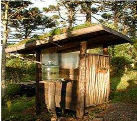
Figura 6.92 – Foto do sanitário seco da ecoaldeia.
