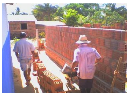
Figura 38: Carregando tijolos. Fonte: Arquivo da escola.
