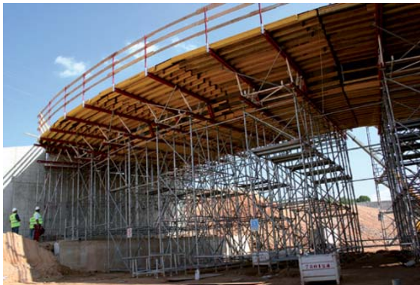
Dos equipos de cimbra y un encofrado
