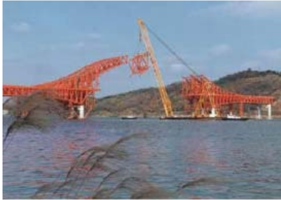
Colocación de dovelas del arco
