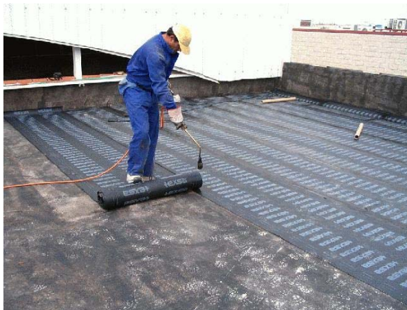
Membrana asfáltica sobre azotea
