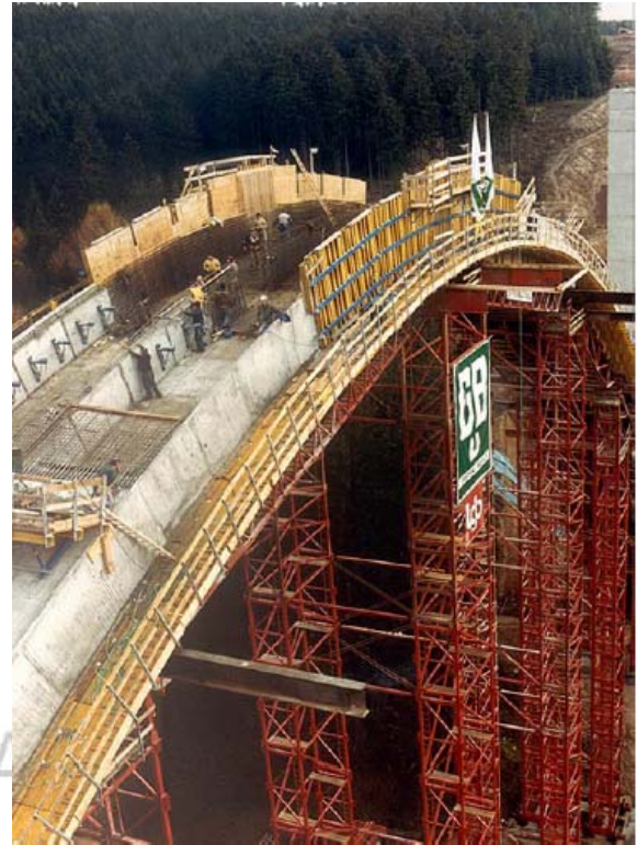
Detalle de sección en cajón del arco
