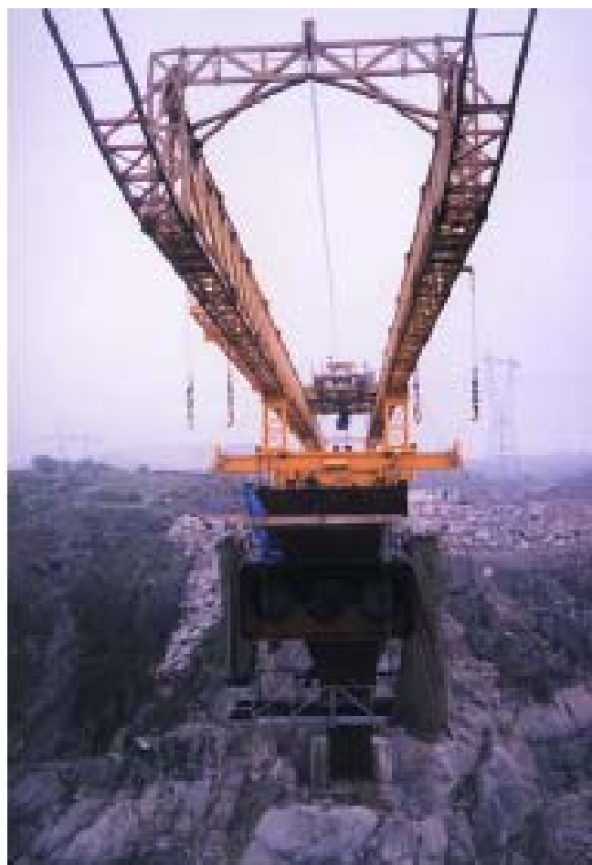
Lanzamiento y colocación de dovela del arco
