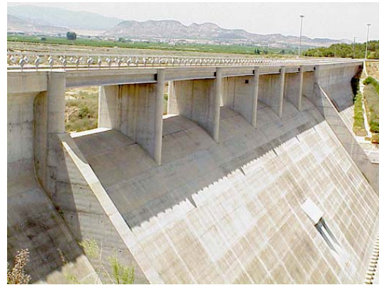
Toma de aliviadero de compuerta sector
