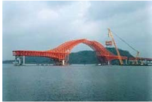
Colocación de la dovela central del arco
