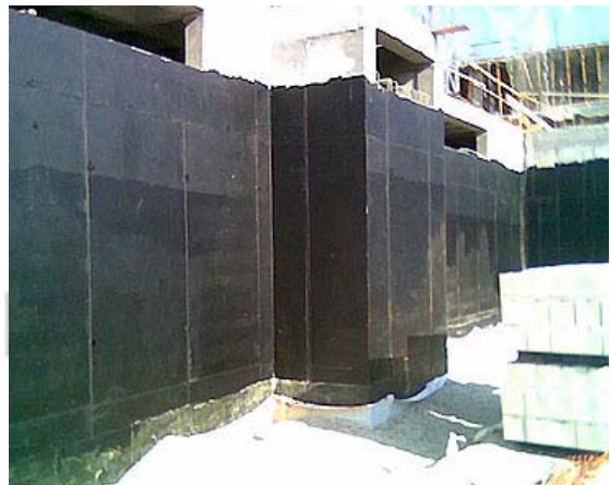
Impermeabilización muro con pintura asfáltica
